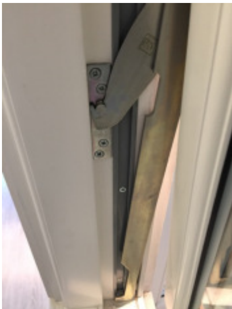
Låst fönsterbåge i vädringsläge
